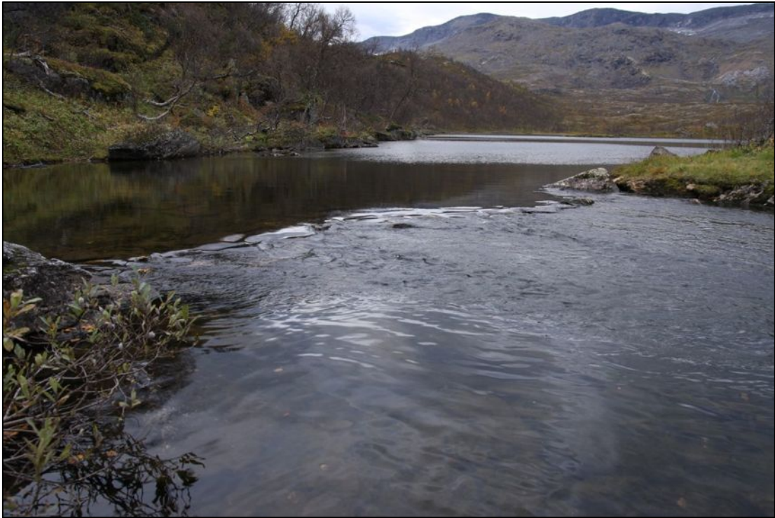
Figur 5. Hammervatnet er hevet med 18 cm pga steinterskelen som er bygget i utløpsosen. Strømning over steinterskel i vises tydelig, Vannføring ca. 300 l/s, målt vannstand ved inntak 372.81, målt vannstand i Hammervatnet 372.91. Naturlig vannstand for denne vannføringen ville vært 372.86. (Etter Hydrologirapport Nordkraft). Oppstuvning i denne situasjonen pga inntakskonstruksjonen er på 5 cm, godt innenfor naturlig regulert sone. Foto: Ingve Birkeland.
