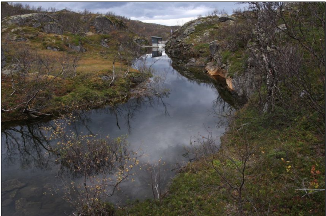
Figur 4. Virakelva rett oppstrøms inntaksområdet. Bildet viser at den for høye damkrona gir en oppstuvet vannflate mellom inntaksdammen og steinterskelen i utløpet av Hammervatnet. Foto: Ingve Birkeland.
